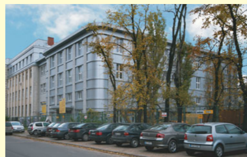
Modernizacja i rozbudowa Szpitala Inflancka
