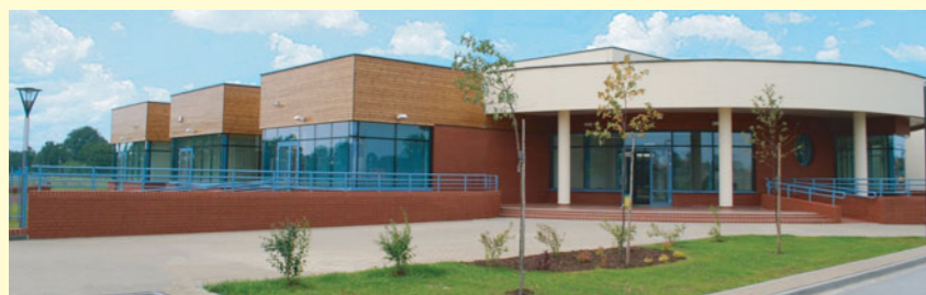
Budowa przedszkola przy ul. Ostródzkiej (Białołęka)
