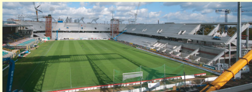
Budowa stadionu przy ul. Łazienkowskiej
