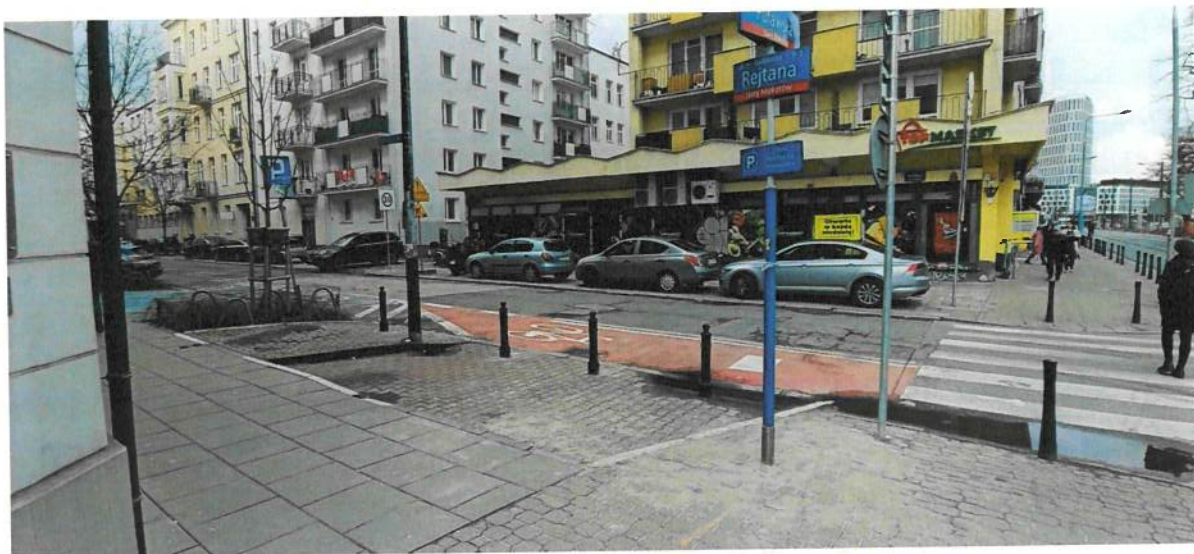
Załącznik - zdjęcie miejsca do odbetonowania
